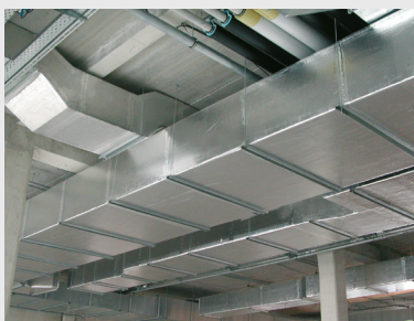
Conduit pré isolé Fib'Air® A2 NETO pour les réseaux de soufflage et de rejet en intérieur de bâtiment et Fib'Air® ALU A2 pour les conduits d'extraction et d'amenée d'air neuf sans contrainte acoustique.
