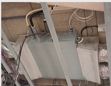
Adaptation de pièces de forme pré-isolées avec piquages dans faux plafond.
